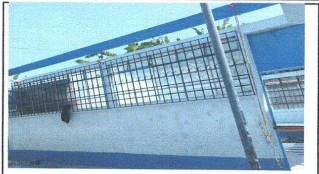
Foto 2: Sustrucción de estructura de soporte
